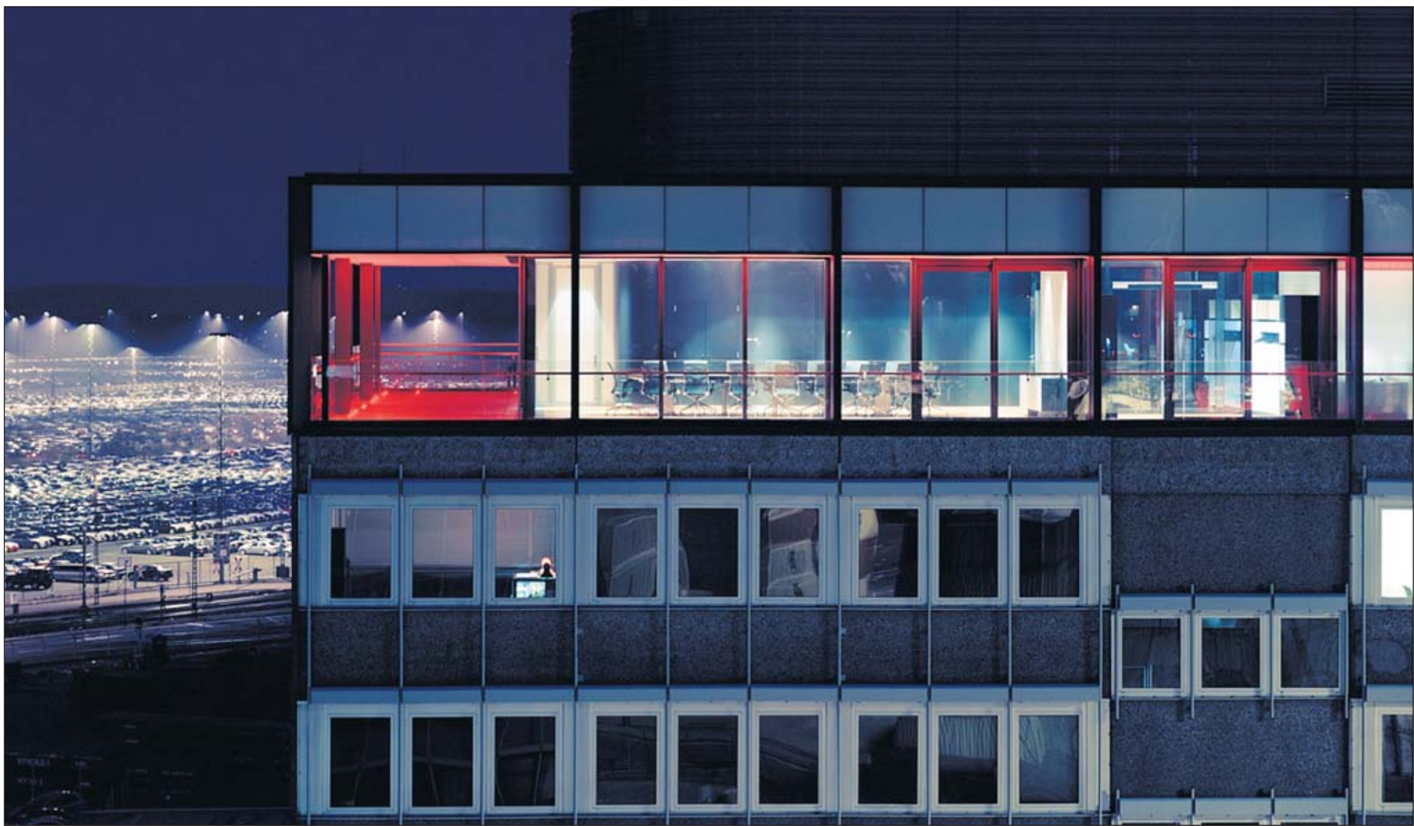
Platz da bei Eurotop: Die Aufstockung des Gatehouses 1 an der Senator-Borttscheller-Straße 1 ist beim bundesweiten Tag der Architektur für Interessierte geöffnet. Der Bau ist von den Architekten Birgit und Jost Westphal aus Bremen für die Firma Eurogate entworfen worden. Foto: Ortmeier
