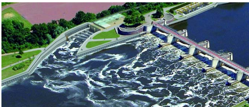
Das in Bau befindliche Weserkraftwerk (hier eine Computersimulation) wird ab 2010 den stetig steigenden Ökostrombedarf mitdecken.
